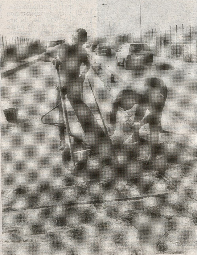
Due (squadre) di operai al lavoro sul Ponte Nuovo impiegano modernissime tecnologie
