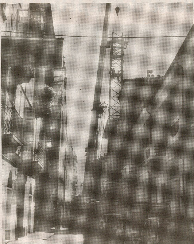
Dopo un anno di inutile attesa la ditta Fantino ha dato il via ai lavori per la ristrutturazione dell'istituto magistrale in via Barbaroux.
