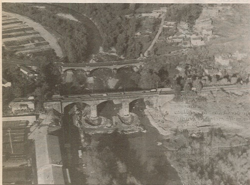
Nella foto il ponte sul Gesso prima dell'alluvione, in primo piano i lavori per il raddoppio. Foto "Ritratti" Boves.
