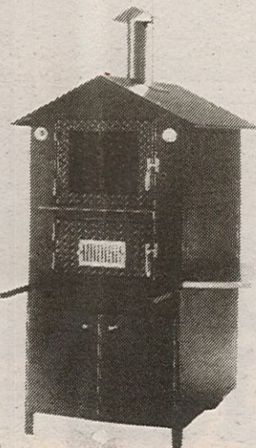
Forno a cottura continua da esterno alimentato a legna
