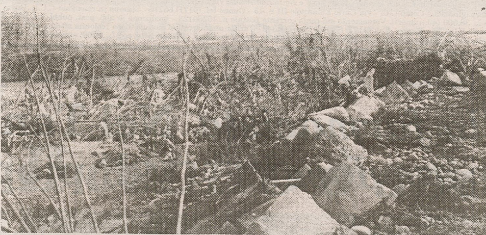
Nella foto sopra: l'intreccio dei pioppi distrutti all'interno dell'argine del fiume, dove il terreno dovrebbe essere libero per permettere all'acqua di scorrere. Nella foto sotto: all'esterno dell'argine l'impiantamento di pioppi ormai distrutti. Da notare che il livello del terreno è più basso di circa due metri rispetto al piano iniziale; del terreno è stato tolto il prezioso ghiaione.
