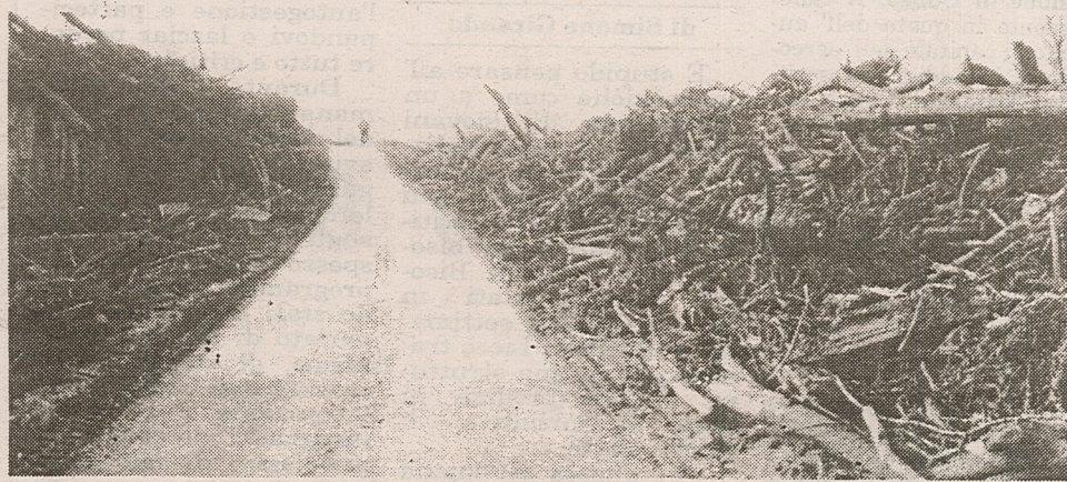
Nella foto a destra: un esempio di barricata di pioppi che l'acqua ha accumulato contro la strada, determinando l'effetto diga.
